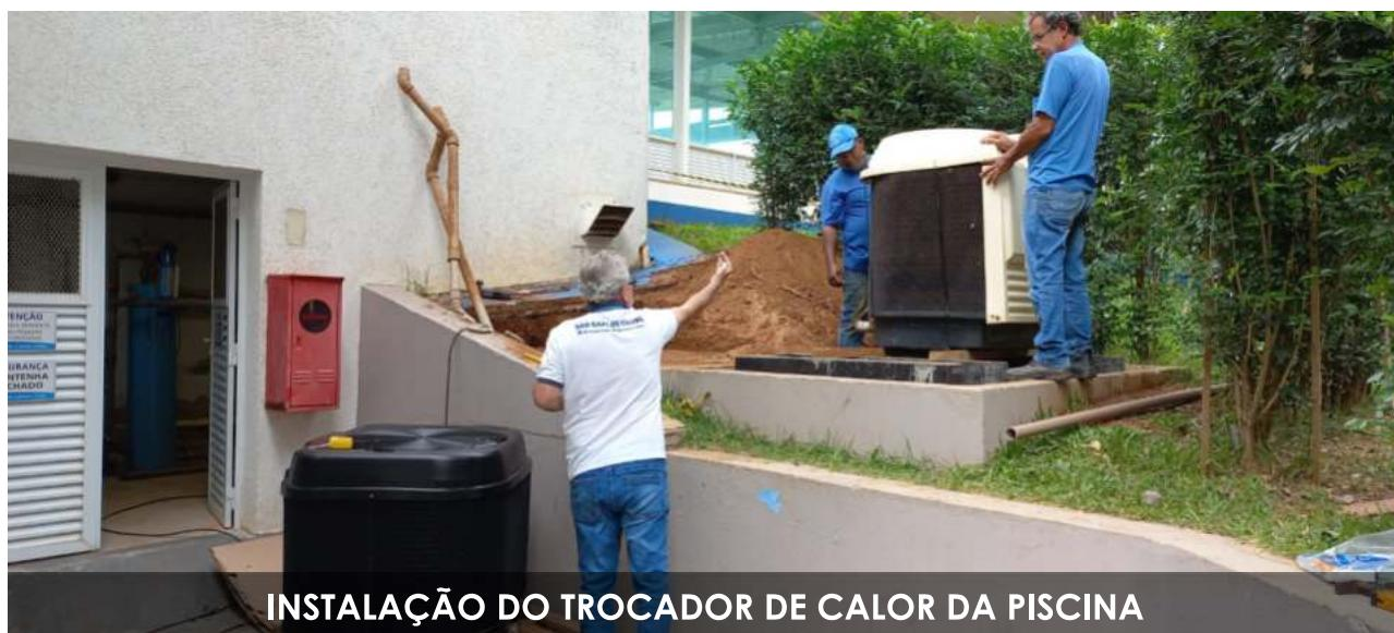
INSTALAÇÃO DO TROCADOR DE CALOR DA PISCINA
