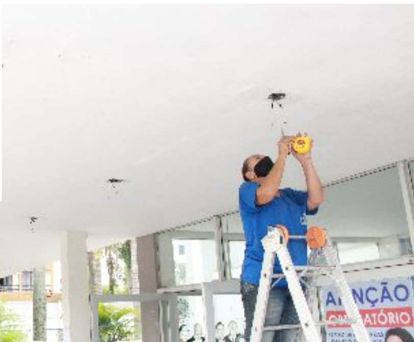
Troca dos spots de luz da entrada da Fitclube Academia
