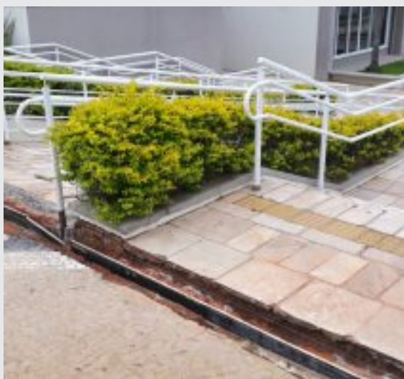
Manutenção de grelha da água pluvial na rampa de acesso à piscina e Estacionamento 2
