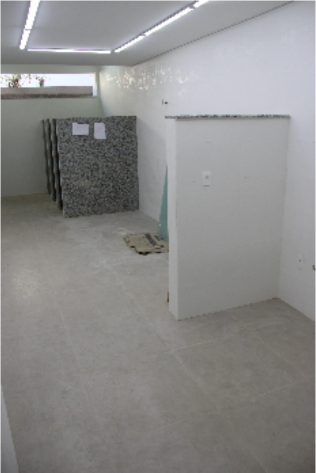
Banheiro Masculino: Aumento na quantidade de cabines e mictórios. Os dois sanitários estão sendo completamente renovados, seguindo o padrão do Clube. Além disso, um novo sanitário PNE está sendo construído.
