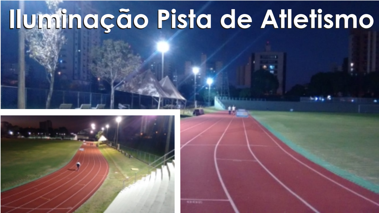
Um novo sistema de iluminação foi parcialmente instalado na Pista de Atletismo e está em fase de testes. Por esse motivo, apenas um lado da pista está com a nova iluminação. Com a finalização da montagem, o associado desfrutará de um local com muito mais luminosidade para suas práticas noturnas de corrida e caminhada. As lâmpadas de LED são 80% mais econômicas que as incandescentes, sustentáveis e têm baixa emissão de calor.
