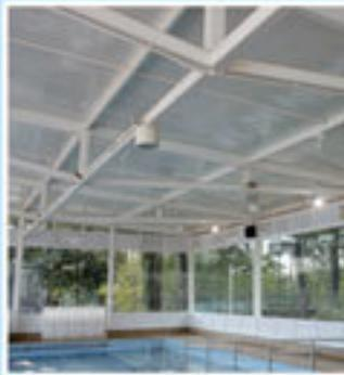
**Telhado da piscina aquecida** – O telhado será totalmente reconstituído, utilizando-se o sistema de cobertura zipada. A cobertura contínua, por meio de uma “costura” que não deixa frestas entre os perfis e dispensa o uso de parafusos ou fitas de vedação, evita vazamentos durante as chuvas e traz conforto térmico e acústico.
