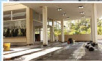
**Academia: impermeabilização, acessibilidade e pisos externo e solário** – A impermeabilização do piso visa evitar infiltração e vazamento, durante as chuvas, no pavimento térreo, onde estão localizadas as salas de jogos e leitura. A troca do piso por outro com aderência evita escorregões quando em contato com a água. Já a adequação das rampas e a implantação de corrimãos estão de acordo com a norma de acessibilidade NBR 9050/04.
