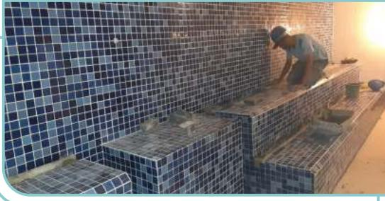
A Sauna passou por reforma completa. A parte hidráulica, elétrica, pisos e revestimentos foram substituídos. Um novo equipamento de vapor e nova tubulação em aço inox foram instalados no local
